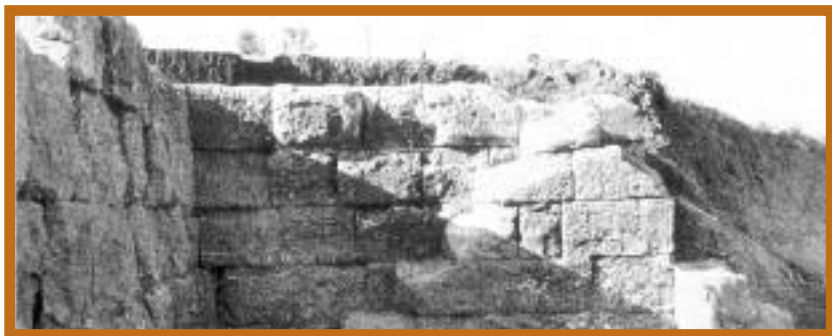
Particolare delle mura della cisterna (BSR Archive, collezione J. B. Ward Perkins, SEID38-039d)
